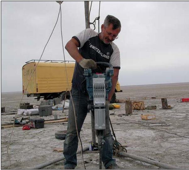
Бурение скважины на сухом дне Аральского моря.
